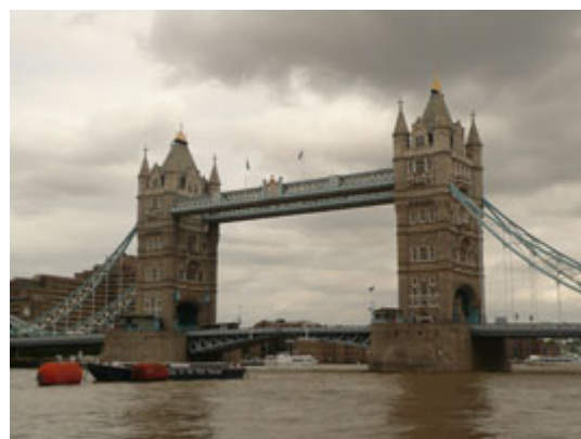
Puente de la Torre.
