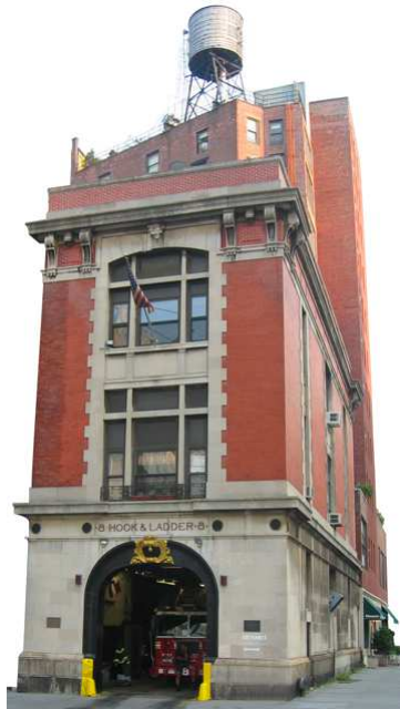
Edificio de los Cazafantasmas.
