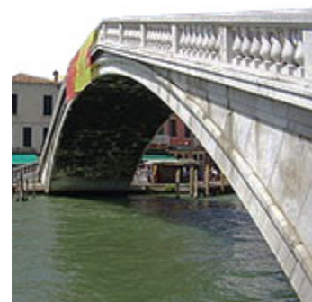
Ponte degli Scalzi.
