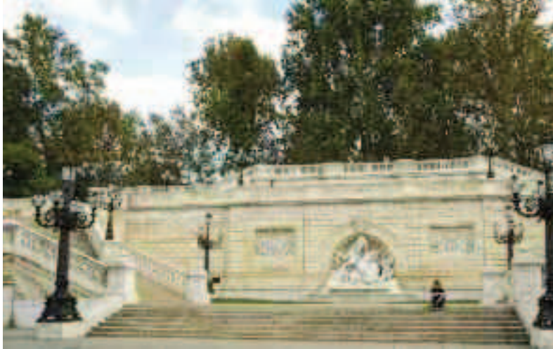
Escalinata del Pincio (Montagnola) Provincia de Bolonia
